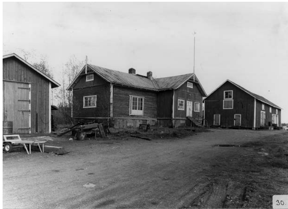
48. Oulujoen Uittoyhdistys ylläpiti Tukki-saaren rakennuskantaa vielä 1970-luvulla. Etualalla on vaja, keskellä on ruokalarakennus ja perällä Eino Pitkäsän vuonna 1937 suunnittelema suuri varastorakennus. Näistä ainoastaan vajarakennus on säilynyt. KUVA: Pohjois-Pohjanmaan museo, kuvaaja Pentti Väisänen
