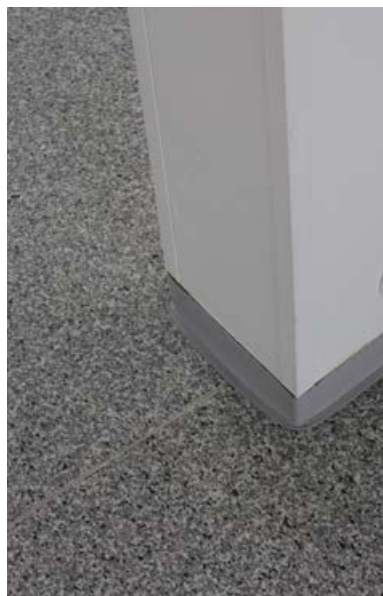
164. Kokoontumistiloissa lattia on tummanharmaa. Listoitus on tehty muovisella L-listalla.
