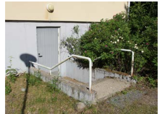
146. Itäpäädän kellarin laskeudutaan betoniportaita pitkin. Ovi on muodoltaan vuoden 1947 oven kaltainen.
