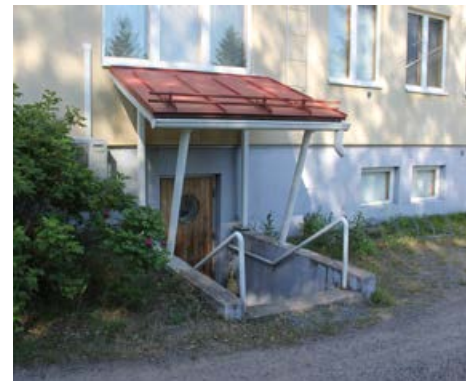
145. Kellarin saunaosastolle ja teknisiin tiloihin johtava sisäänkäynti on katettu. Merellinen ovi on lisätty 1996.
