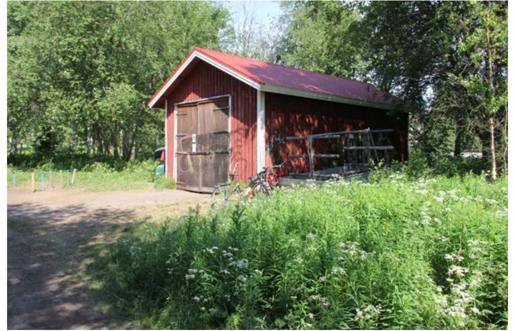
105. Vanha varastorakennus on Uiton talon lisäksi ainoa Tukkiisaaren erottelupaikalla säilynyt rakennus. Se toimii nykyisin melontaseuran kanoottivarastona.
