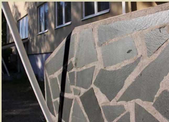
122. Vuoden 1996 peruskorjauksessa porraskaiteet verhoiltiin 1950-luvun tyyliin luonnonkivellä. Katoksen teräksiset vinotuet puolestaan edustavat kyseisen aikakauden tyyliä.
