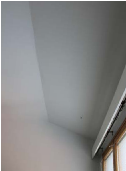
156. Toisen kerroksen alakatto on kaksitaitteinen. Alkuperäinen muoto on säilynyt alaslaskusta huolimatta.
