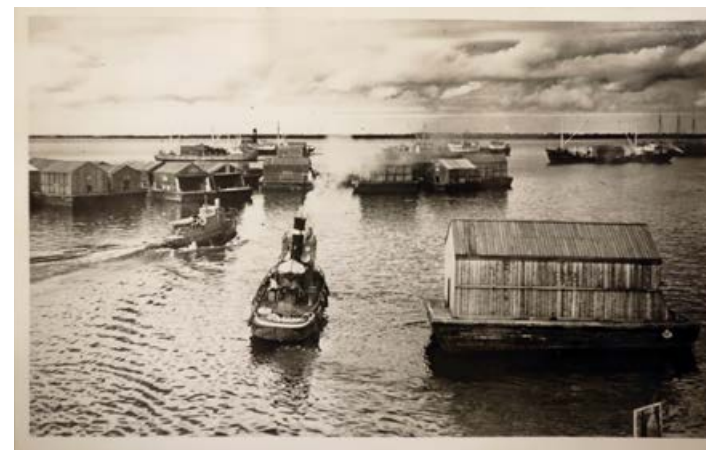
31. Sisämaan savotoilta uitettu ja rannikon sahoilla jalostettu puutavara jatkoi matkaa laivoilla kohti kaukaisia vientimaita. KUVA: Kansallisarkisto, Oulujoen Uittoyhdistyksen kokoelma
