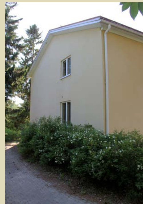
121. Rakennuksen itäpääty on varjoisa. Siellä ei ole sisäänkäyntiä, mutta kivetys kiertyy joen puoleiselle pihalle.
