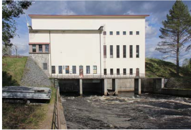
293. Katerman voimalaitos Kuhmossa (1950) on yksi neljästä Pitkäsen toimiston Kajaani Osakeyhtiölle suunnittelemissa vesivoimalaitoksista. KUVA: Veli-Pekka Huhmo
