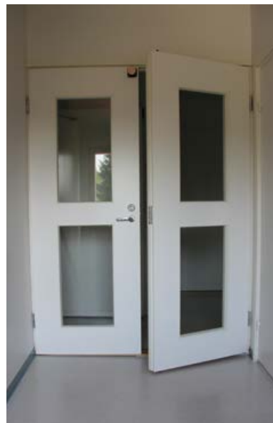
173. Toisen kerroksen porrashuoneen pariovi.
