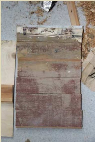
149. Toisen kerroksen asuinhuoneen lankkulattia on säilynyt muovimattojen alla.
