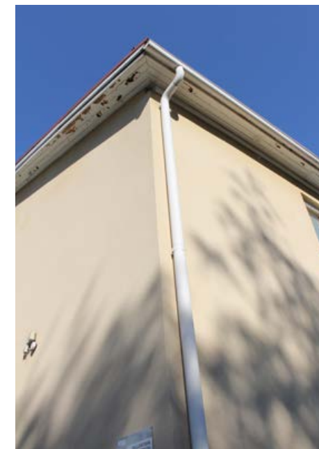
130. Rakennuksen pitkillä sivuilla on kolme pyöreää syöksytorvea.
