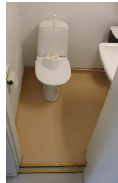
168. Vanhimmissa WC-tiloissa on käytetty ruskeaa muovimattoa.
