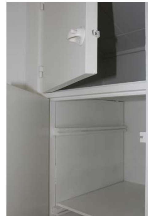
195. Vanha komero on puusepän työtä. Vetimenä on 1950-luvulla suosittu Leea-salpa.
