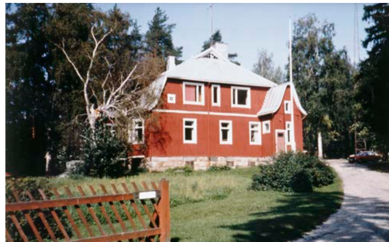
36. Oulujoen Uittoyhdistyksen konttorirakennus Kajaanissa on rakennettu vuonna 1920. Sen on suunnitellut arkkitehti Hugo Laitinen. KUVA: Pentti Karjalaisen kokoelma / Lusto
