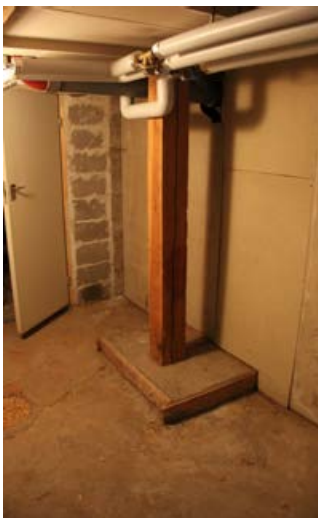
281. Entisessä maantutkimuslaboratorion verstaassa välipohjan kannatusta on vahvistettu puupilarilla
