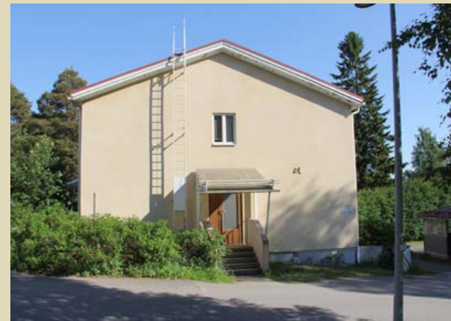
120. Länsipäätyyn on lisätty katos sekä tikkaat. Ulko-ovi on uusittu 1950-luvulla.
