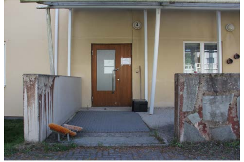
144. Koskitien puoleinen sisäänkäynti on muotoiltu esteettömäksi. Liuskekivillä verhoiltu betoni-kaide ja pitkälle ulottuva valokate suojaavat oven edessä olevaa tasannetta.
