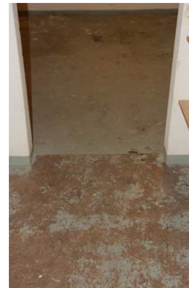
170. Itäpäädyn kellarissa on alkuperäinen maalattu betonilattia.
