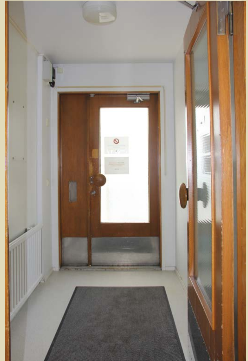
218. Rakennuksen sisätilojen vallitseva 1990-luvun kerrostuma on laitosmainen. Kuvassa näkyvässä Koskitien puoleisessa sisäänkäynnissä on säilynyt 1950-luvun lopun ovia.
