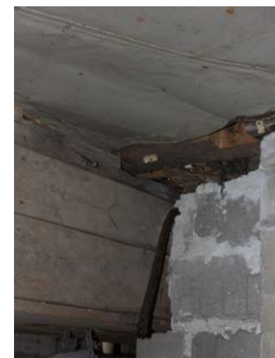
285. Kellarin alakattoa on vuorattu sinkkipeltilevyillä.
