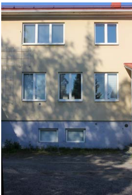
135. 1950-luvulla tehtiin uusi ikkunajako. Vaakaikkunoiden joukkoon lisättiin kaksijakoisia pystyikkunoita.
