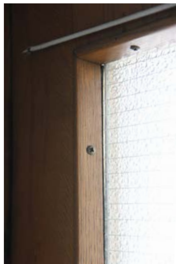
227. Tammissen ulko-oven yksityiskohta
