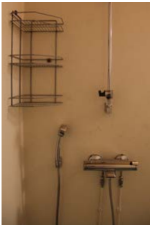
211. Suihkuhuoneen vesikalusteet ovat 1990-luvulta.
