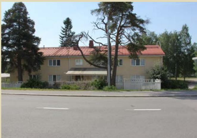
119. Rakennus kohtisuoraa Koskitien yli nähtynä. Tien korko on noussut aikojen saatossa ja rakennus on jäänyt painanteeseen.
