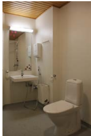
213. WC:n kalusteita on uusittu 2000-luvulla
