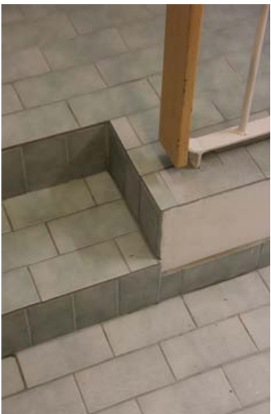
169. Länsipäädyn kellarissa on vaaleansininen keraaminen laattalattia.
