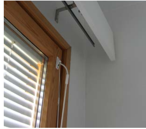
187. Ikkunoissa on sälekaihtimet sekä verholaudan taakse kätetty verhokisko.
