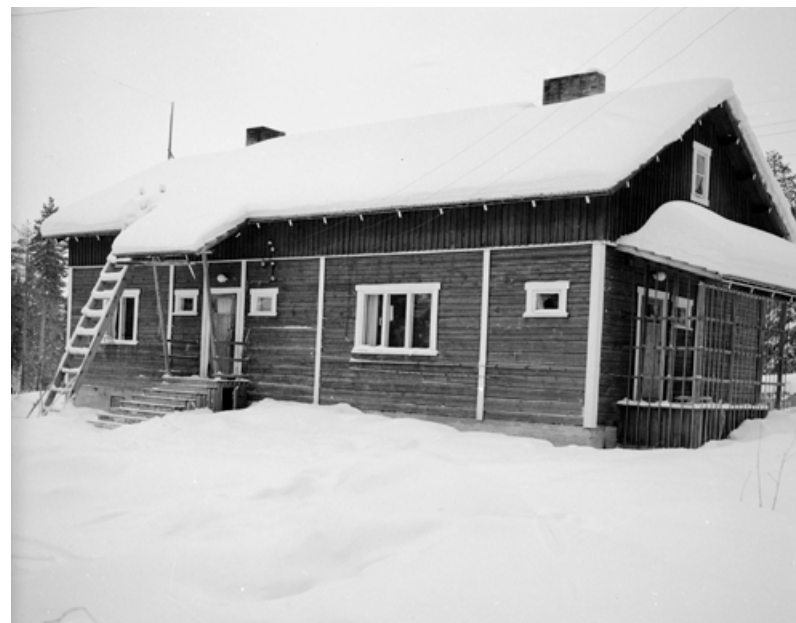
37. Arkkitehti Eino Pitkäsén suunnittelema Oulujoen Uittoyhdistyksen piiriesimiehen asuintalo Ämämänsaaressa on. vuodelta 1946. KUVA: Elias Purhonen / Elias Purhosen kokoelma / Lusto
