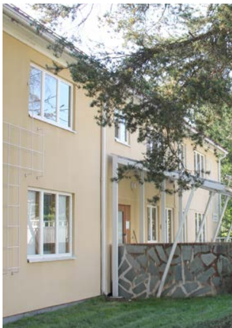
126. Koskitien puolella sadevesi ohjataan loiskekupin kautta pihalle. Maa viettää rakennuksen suuntaan.
