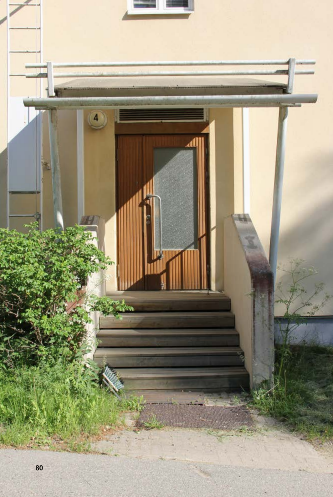
138. VASEMMALLA: Länsipäädyn sisäänkäynti on alkuperäisellä paikalla. Se sai nykyisen muodon vuoden 1958 muutostyöskorjauksessa. Katos ja betonikaiteet ovat 1990-luvulta.
