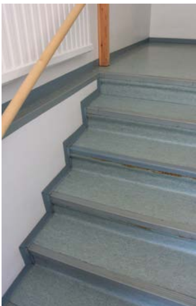
166. Porrashuoneen vihreä muovimatto on todennäköisesti 1990-luvulta.
