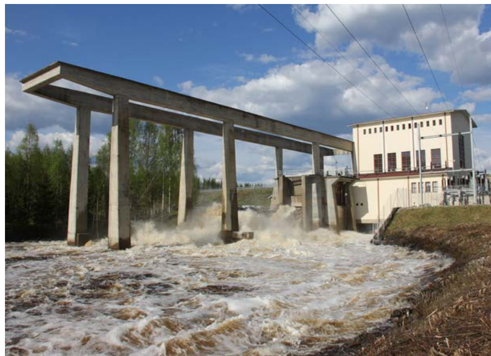
38. Oulujoen voimalaitosten yhteyteen rakennettiin vuosina 1954-1963 massiiviset nipunsiirtolaitteet, joiden kustannuksista vastasi valtio. Kuvassa on Eino Pitkäsän arkkitehtitoimiston suunnitteleva Kallioisten voimalaitos Sotkamon reitiltä. KUVA: Veli-Pekka Huhmo
