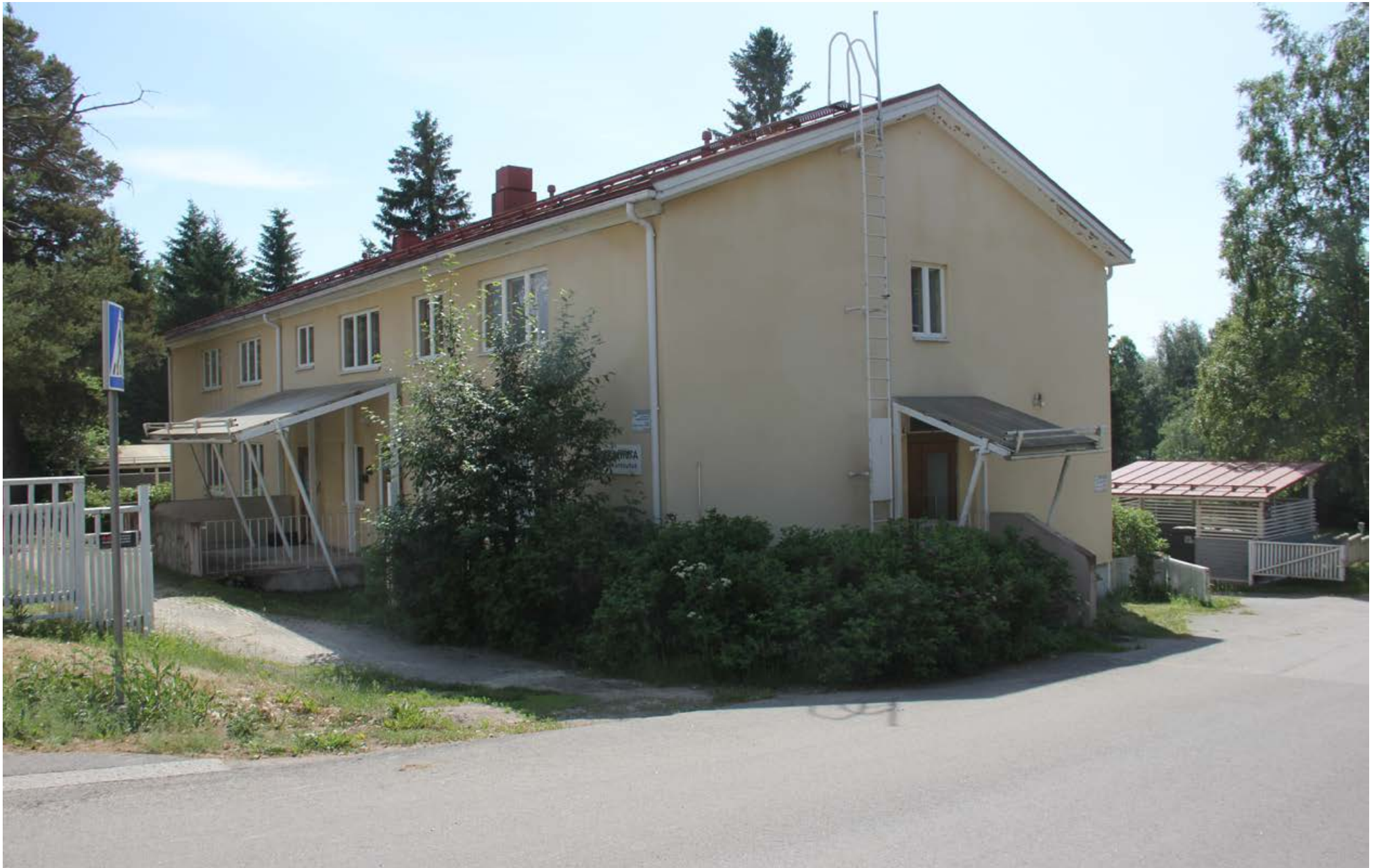
124. Julkisivu Koskitielle länsipäädystä nähtynä.
