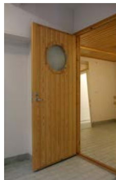
179. Merellinen paneeliovi kellarin saunaoasastolta.
