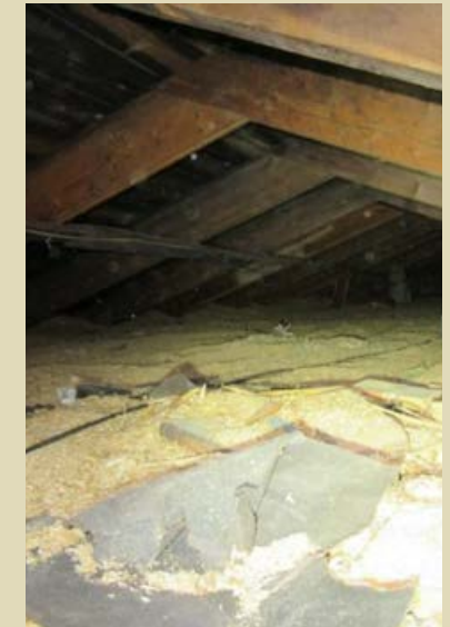
151. Ullakkotila on matala kolmiomainen laipio. Eristeenä on kutterin- ja sahanpurua. KUVA: Sitowise
