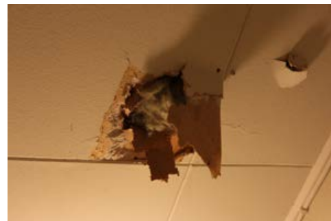
162. Kellarista nousevassa sisäporrashuoneessa on säilynyt vanha puukuitulevykatto.
