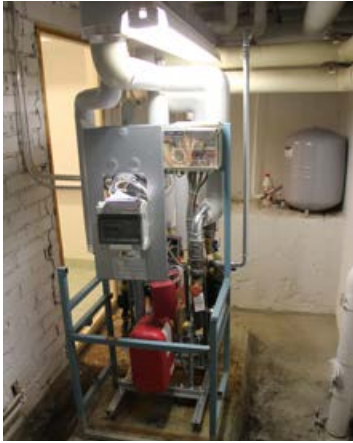
207. Kaukolämmön lämmönvaihdin on uusittu vuonna 2017.
