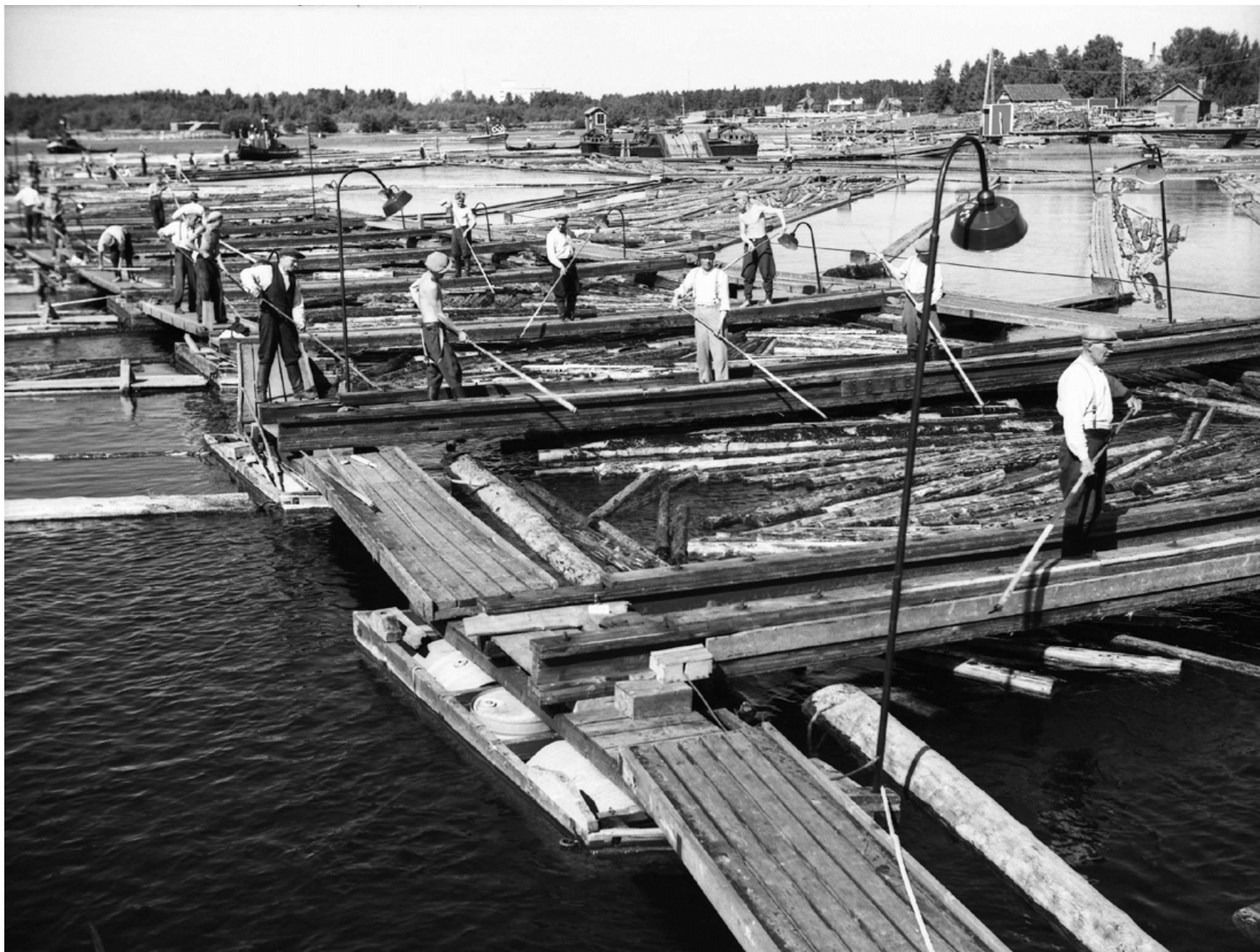
44. Erottelu käynnissä. 1940-luvun lopulla erottelupaikka oli varustettu sähkövalaisimilla. Kuvan keskellä näkyy tukkien niputuslaitos. Oikeassa reunassa näkyvät sauna ja paja ovat Tukkisaa-resta sillalla erotetussa saaresta. KUVA: Mauno Manneinin kokoelma
