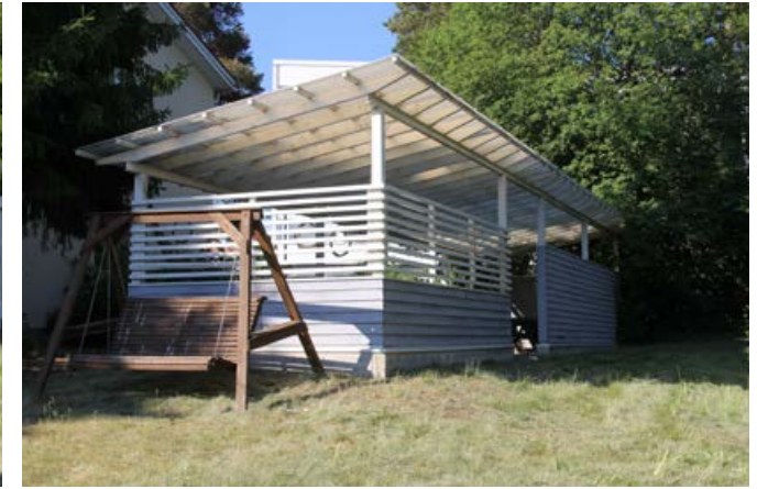
112. Valokatteinen pergola ja sen jatkeella oleva kuivauskatos on sijoitettu talon eteläpäätyyn.
