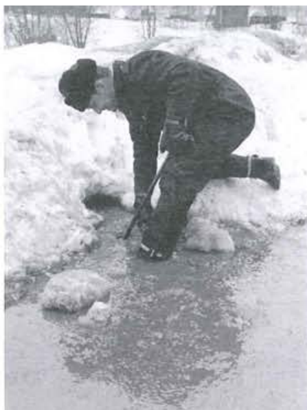
72. Jäätynneen sadevesiviemärin avaus jäi katsastusmiehen tehtäväksi. KUVA: Lauri Myllylän kokoelma
