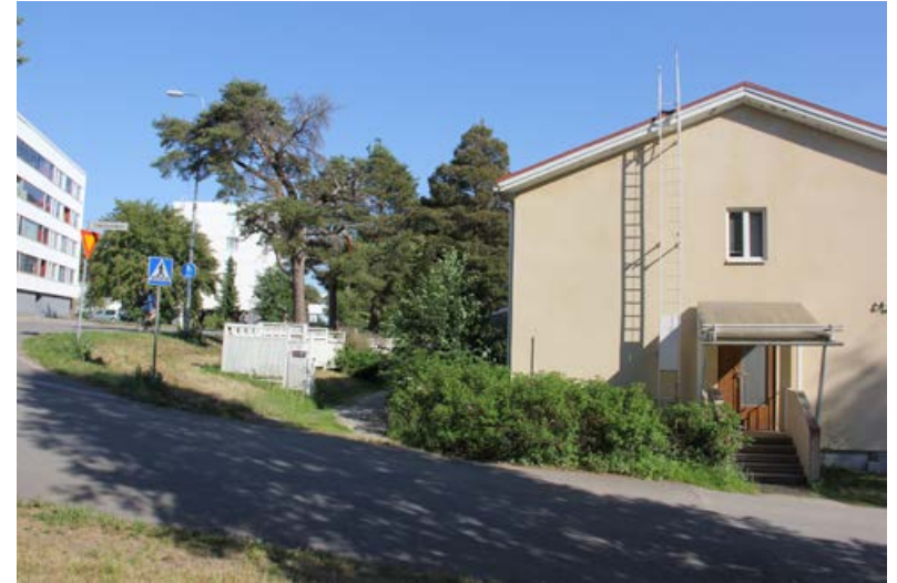
137. Esteetön sisäänkäynti on tehty Koskitien puolelle, jossa maa on ensimmäisen kerroksen tasalla.
