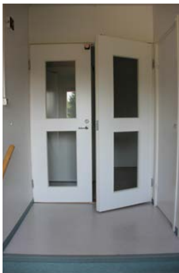
226. Toisen kerroksen ylätasanne.
