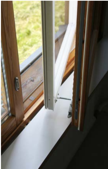
183. Ikkunan alaosa avattuna.
