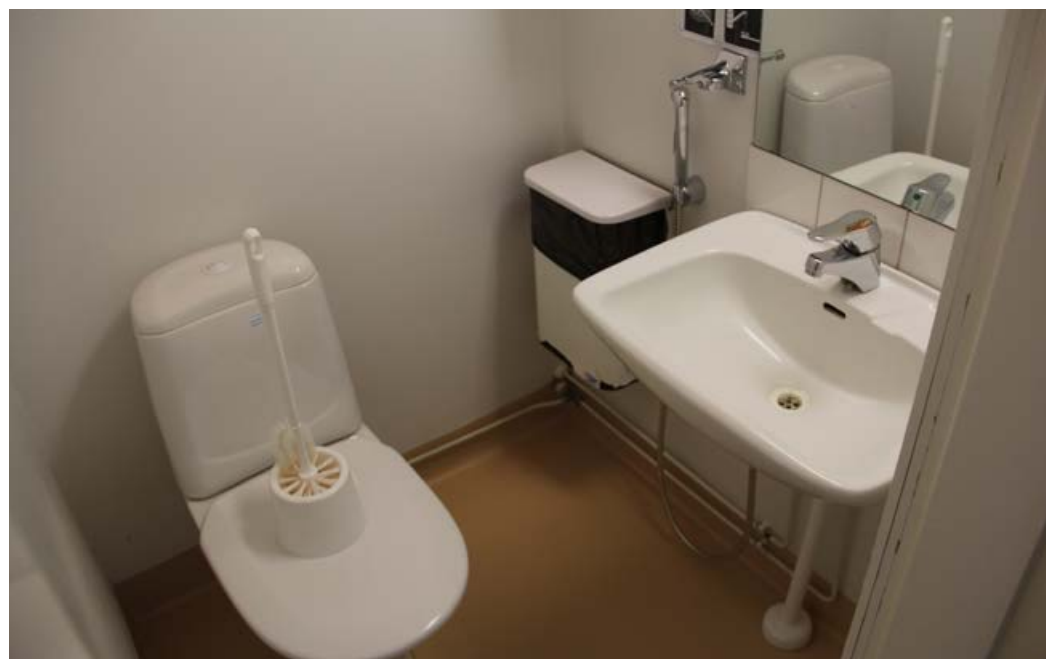
254. Toisen kerroksen wc:n lattia on päällystetty ruskealla vinyylimatolla. Vesikalusteet ovat 1990-luvulta. Vesijohdot on toteutettu pintavedolla.
