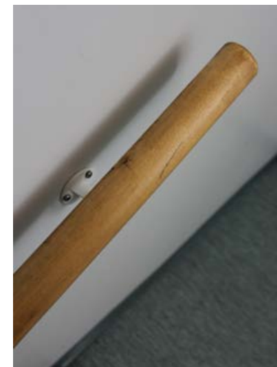
229. Pyöreä koivusta tehty käsijohde on uusittu 1990-luvulla.
