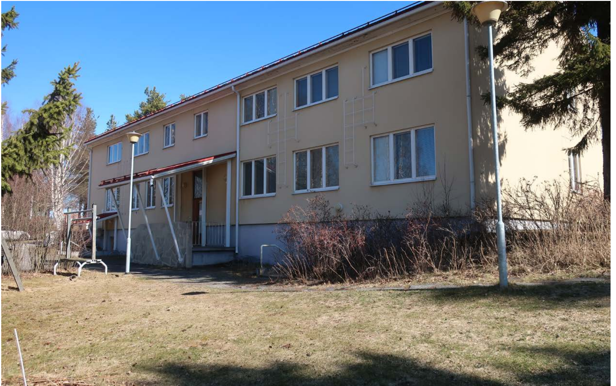
123. Julkisivu joen puolelle itäpääsystä nähtynä.
