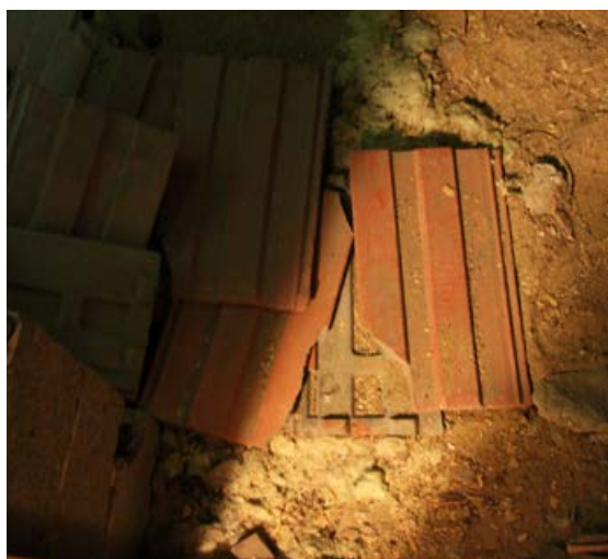
283. 1950-luvulla vesikaton eterniittikate vaihdettiin tiileen. Sementistä tehtyjä valssitiiliä on varastoitu kellarin ryömintätilaan.
