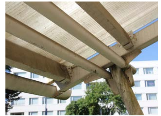
140. Teräsrunko kannattelee sisäänkäynnin valokatetta.
