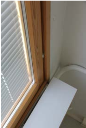
185. Ikkunat on uusittu viimeksi vuonna 1996. Ikkunalauta on iki-laminaattilevyä.
