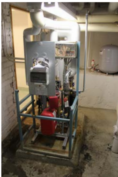
267. Talon lämmityskattila on korvattu kaukolämmön lämmönsiirtimellä 1980-luvulla.
