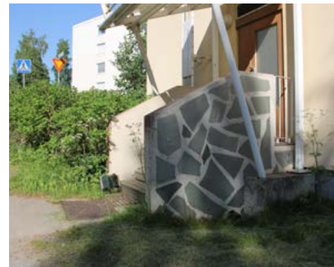
139. Porraskaiteet on tehty betonista ja verhoiltu luonnonkivillä.
