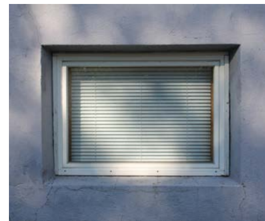
134. Pihan puolelle avautuva kellarinikkuna, jolle vuonna 1996 tehtiin samanlainen pari.
