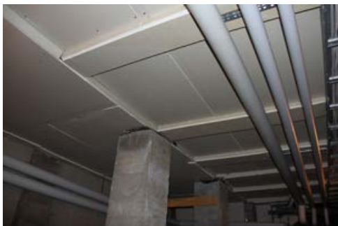
160. Kellarin rakentamattomassa osassa välipohja on suojattu kipsilevyllä.
