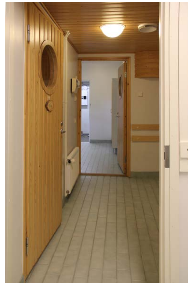
243. Näkymä kellarin sosiaalitilasta saunan pukuhuoneeseen. Kellarin sosiaalitilaa on käytetty etupäässä varastona.
