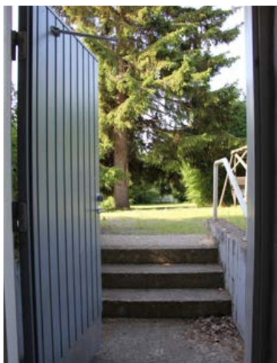
277. Vuonna 1948 tehtyyn kellarin laajennukseen johtaa oma sisäänkäynti. Betoninen ulkoporras on alkuperäinen.
